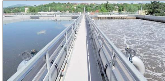
Zmodernizowana oczyszczalnia ścieków w Żywcu jest jedną z najnowocześniejszych w Polsce
