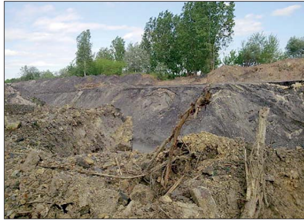
Rozbiórka starej hałdy, której towarzyszy przykry zapach, zakończona zostanie dopiero pod koniec roku
