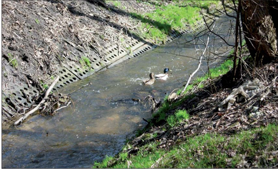
Foto: GIG Katowice
