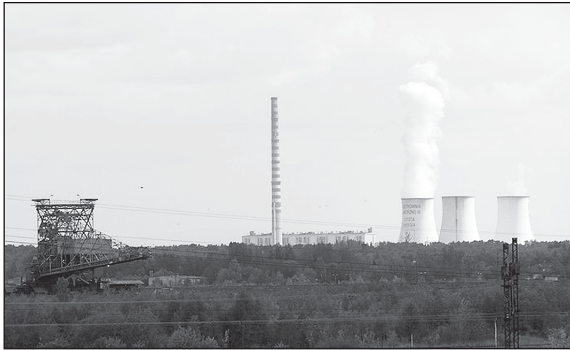
Dzięki nowej inwestycji wszystkie bloki energetyczne elektrowni „Jaworzno III” będą spełniać zaostrome wymogi ochrony środowiska
